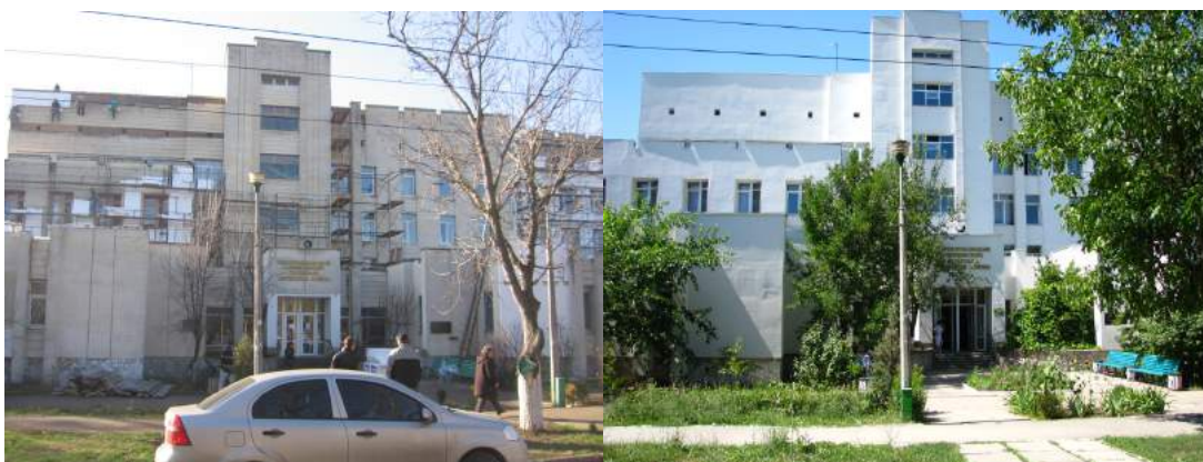
Рис. 2. Санація будівлі, вигляд до і після.
