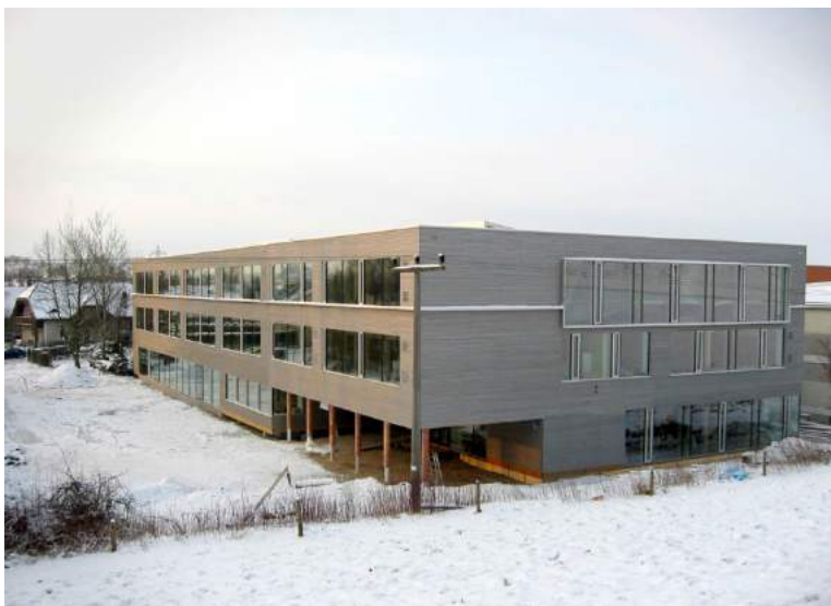
Ремонт школи в місті Шваненштадт (Schwanenstadt), Німеччина
