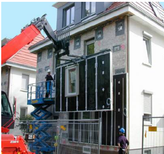
Рис. 5. Утеплення фасадів житлового будинку вакуумними панелями
