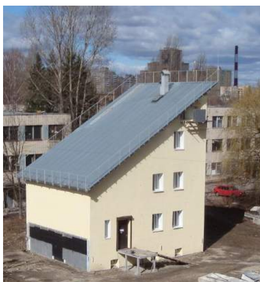
Рис.1. Высокоэнергоэффективный пассивный дом типа «0 энергии»
