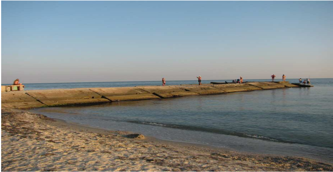
Рис. 1. Изначальный вид облицованной железобетонными плитами буны из набросанных камней Fig. 1. The initial view of the tiled concrete slabs groins of scribbled stones
